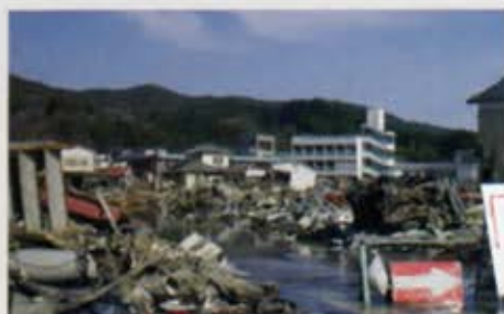
堤防が壊れた沿岸部の町は、満潮時、道路が浸水してしまう。
