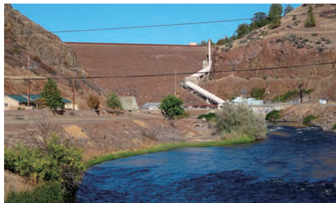
写真3 クラマス川再生のために撤去予定のダム
