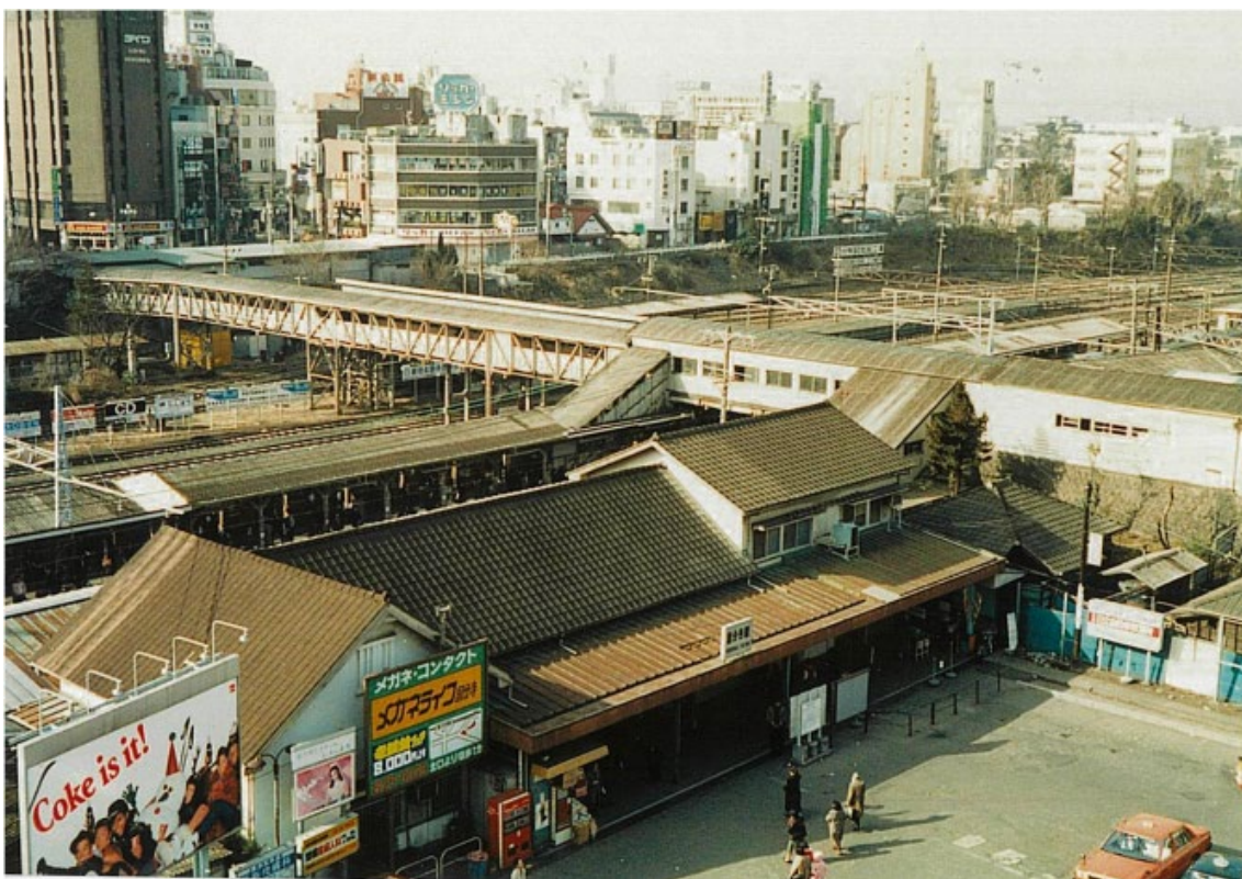
1986(昭和 61)年頃の国鉄国分寺駅南口の様子
